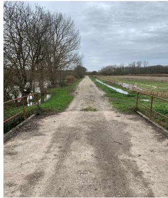
Reprise du chemin du Marais et du chemin de la station d'épuration : Nettoyage accotements, Galbe.
